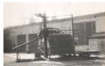
Загальний вигляд розбирача циліндричних упаковок льону
